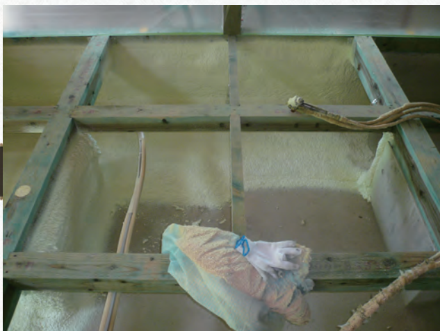
べた基礎土間コンクリートへの吹き付け
