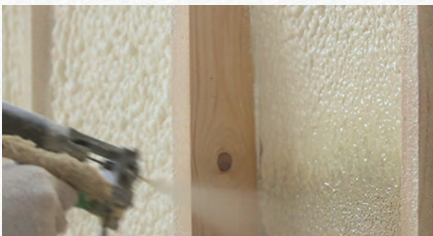
硬質ウレタンフォームの吹き付け施工例（画像提供/ウレタンフォーム工業会）
