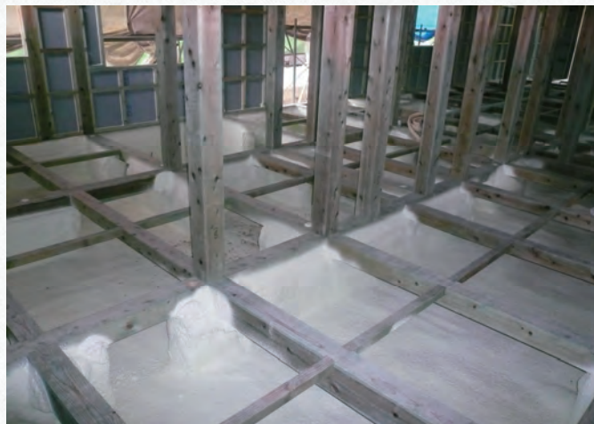
べた基礎土間コンクリートへの吹き付け
