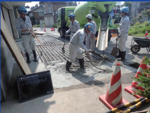
コンクリート打設状況
