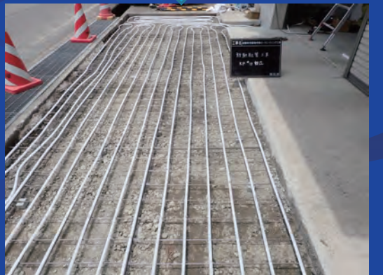
放熱管敷設完了
