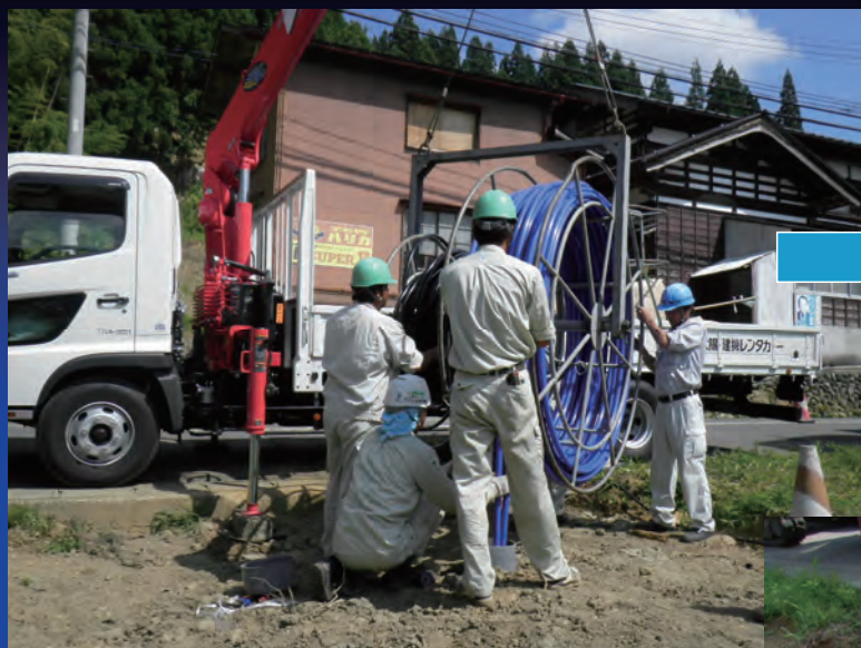
①Uチューブ挿入作業
