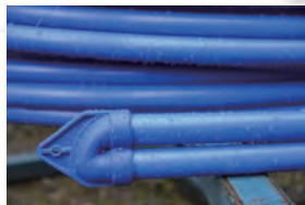
地中熱交換器の施工
