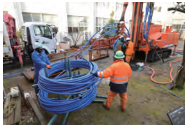
地中熱交換器の施工
