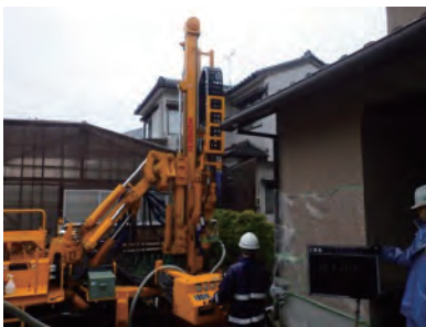
ポアホール掘さく作業
