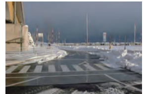
熱利用側の状況 (空調、融雪)
