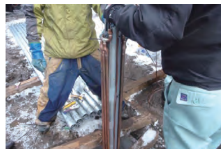
消雪井戸からの採熱管取出し 特殊採熱管(他現場の状況)
