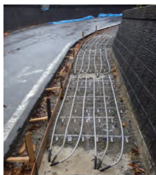
ヒートパイプ敷設状況
