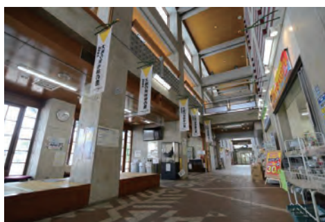
館内の空調エリア
