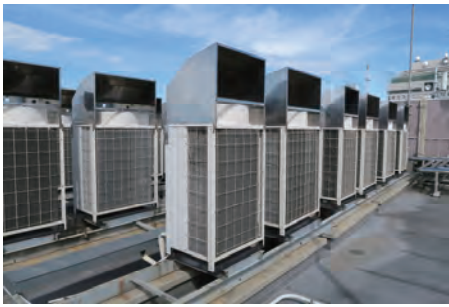
空気熱源ヒートポンプ(屋上)
