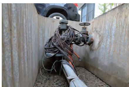
消雪井戸からの採熱管取出し 特殊採熱管(他現場の状況)
