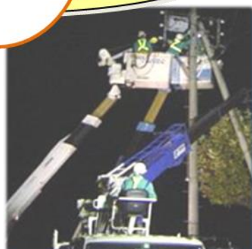
中越沖地震時の深夜復旧作業
