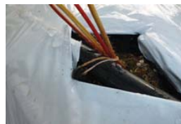
冷水パイプによる“クラウン冷却”
