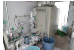
地中熱ヒートポンプ(33.5kW)
