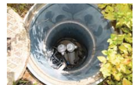
地中熱熱交換器(100m)
